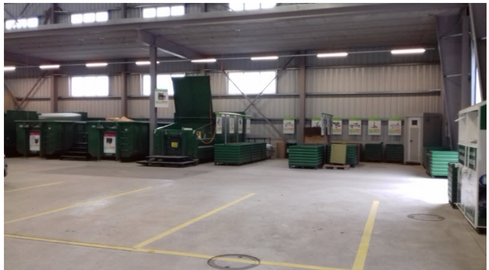
Abbildung 1: Zwischenboden und die darunter stehenden Presscontainer
